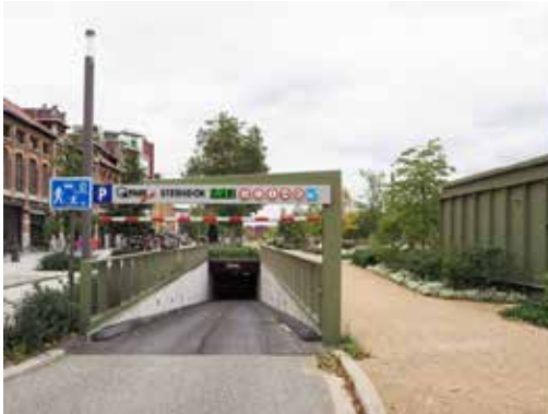
地下駐車場入口
