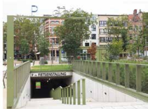
地下駐車場歩行者入口
