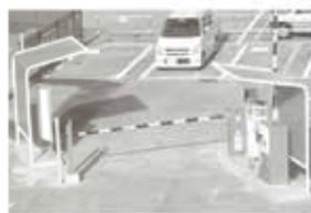
ゲート式駐車場管理システム
