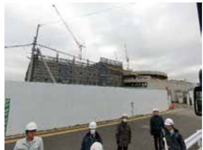
建設中の物流施設
